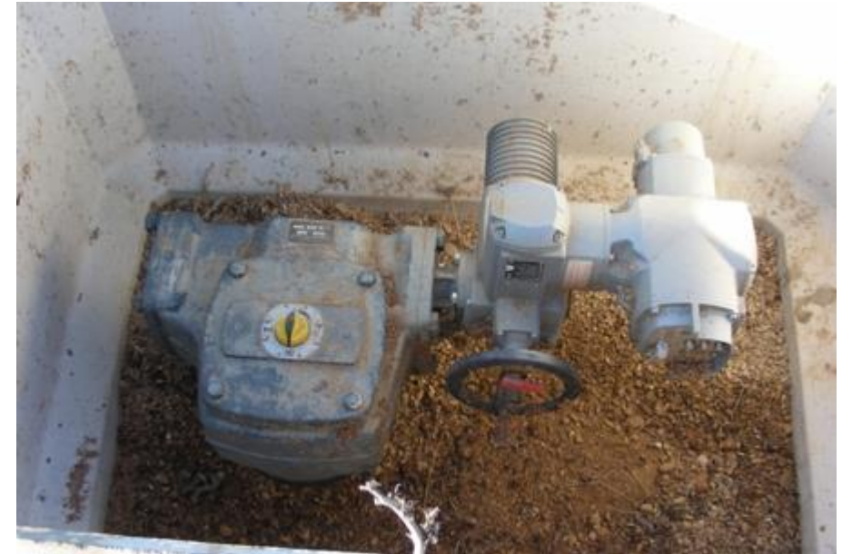
Mantenimiento válvulas de corte
