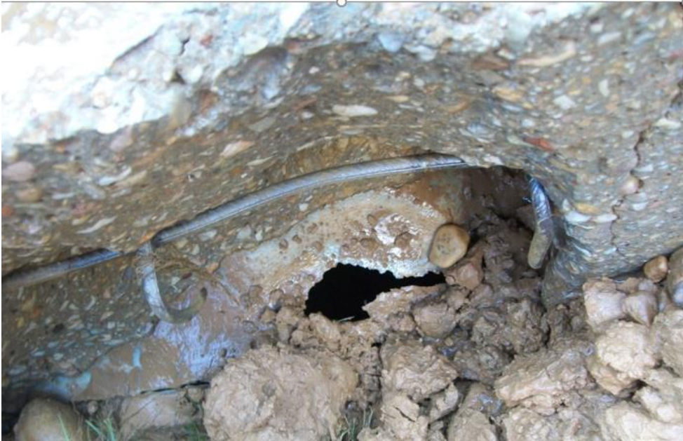
Reparación de fugas
