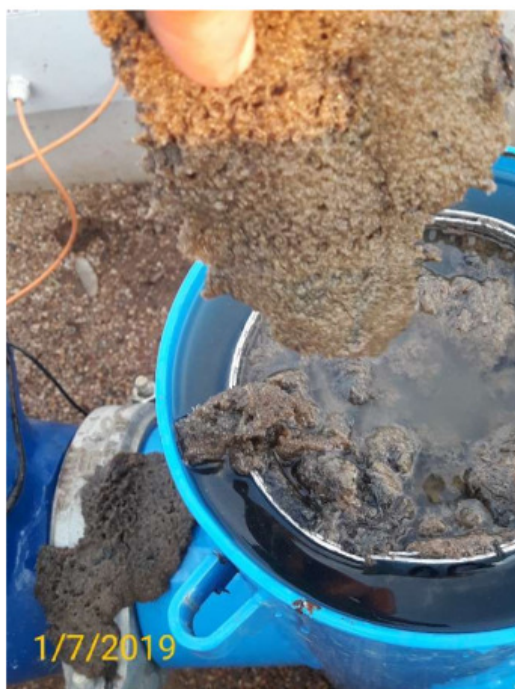
Filtro cazapiedras Sector I – año 2019
